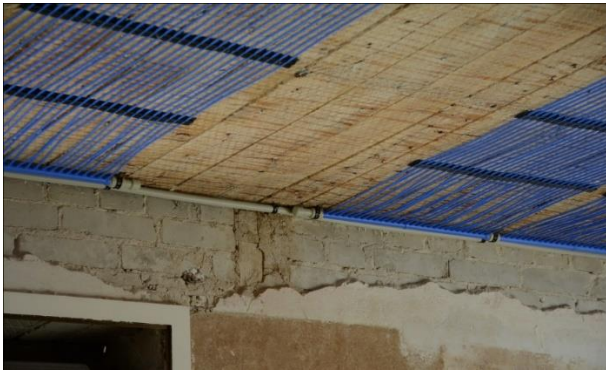
Bild 4: Kapillarrohrmatten mit Haltebänder angeschraubt
