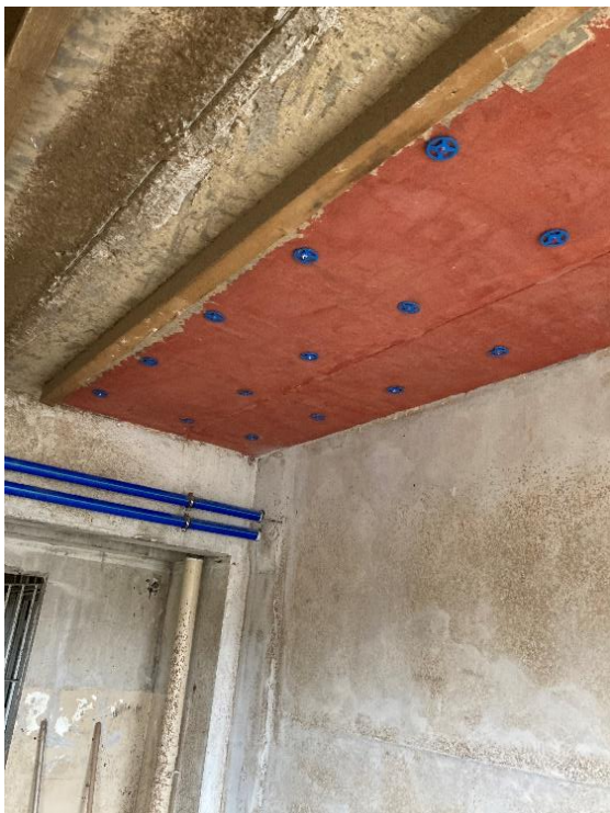
Bild 3: mit PutzPins befestigt
