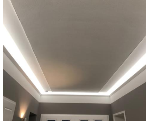
Bild 2: Lehmdecke nach Oberflächenbeschichtung
