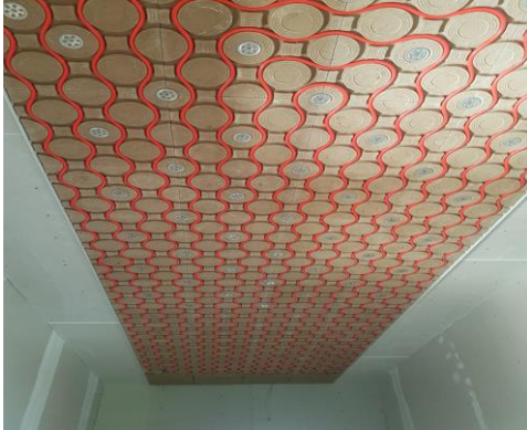
Bild 1: Lehmdecke vor Oberflächenbeschichtung
