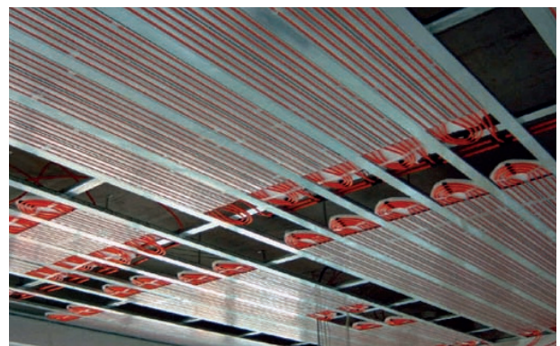
Bild 5: Abgehängtes Deckenheiz-/kühlsystem.
