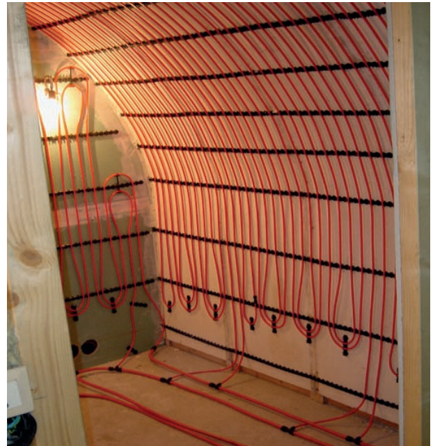
Bild 3: Wandheizsystem für Nassverlegung.
